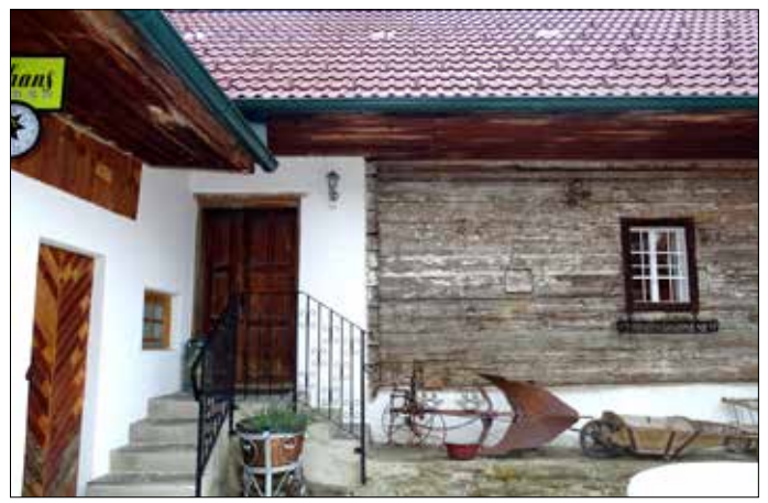
Das Privatmuseum ist im alten Bauernhaus untergebracht.
